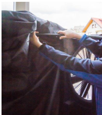
图 16：用伸缩杆将主机固定在窗框上
